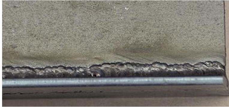
Figura 14. Socavado en el Pie de la Soldadura
