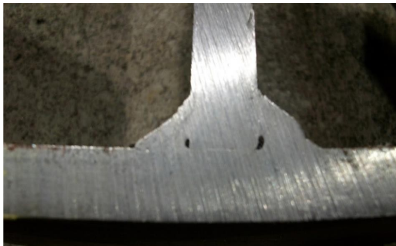
Figura 9. Fusión Incompleta entre Soldadura y Metal Base
