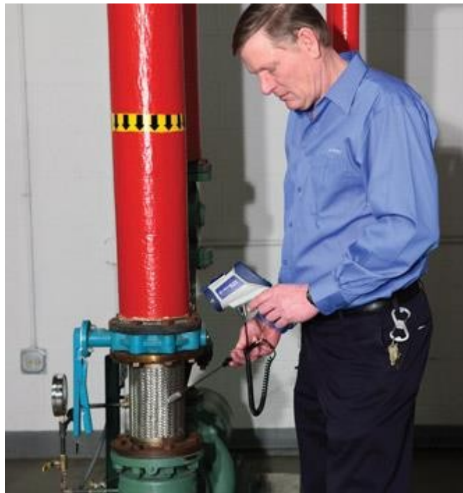
Figura 40. Uso de Un Pirómetro de Contacto Superficial
